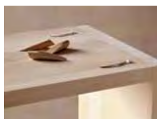
csavarlyuk-lefedő fadugókkal
